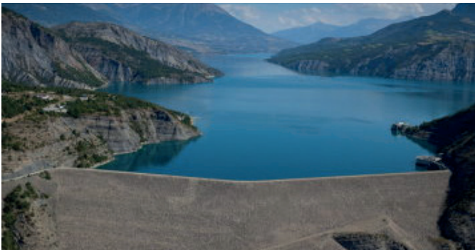
Credit photo : Serre-Ponçon operator EDF
