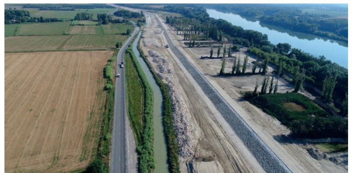
Credit photo : Digue de Camargue. operator SYMADREM
